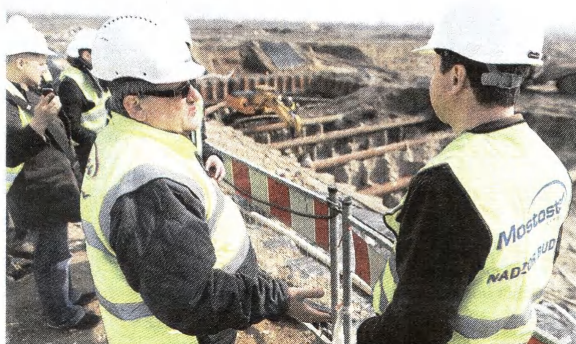
Krzysztof Łabiak, dyrektor kontraktu, przedstawiciel wykonawcy, na placu budowy spalarni tłumaczy radnym, jakiego rodzaju wykonywane są tam teraz roboty w gruncie pod przyszłą instalację.
