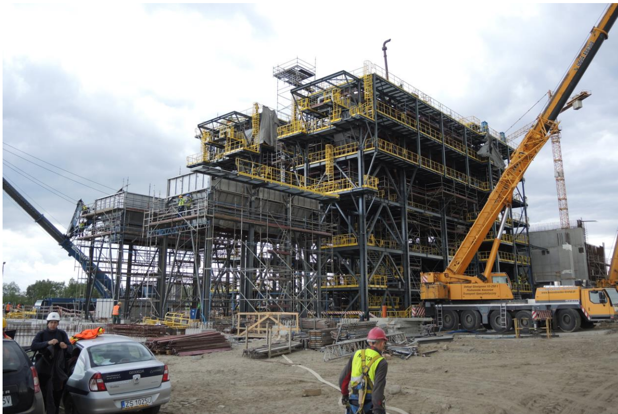
Budowa EcoGeneratora, hala kotłów
