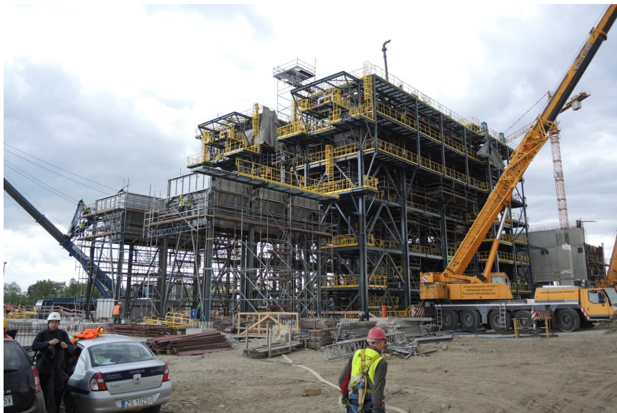
Budowa EcoGeneratora, hala kotłowa
