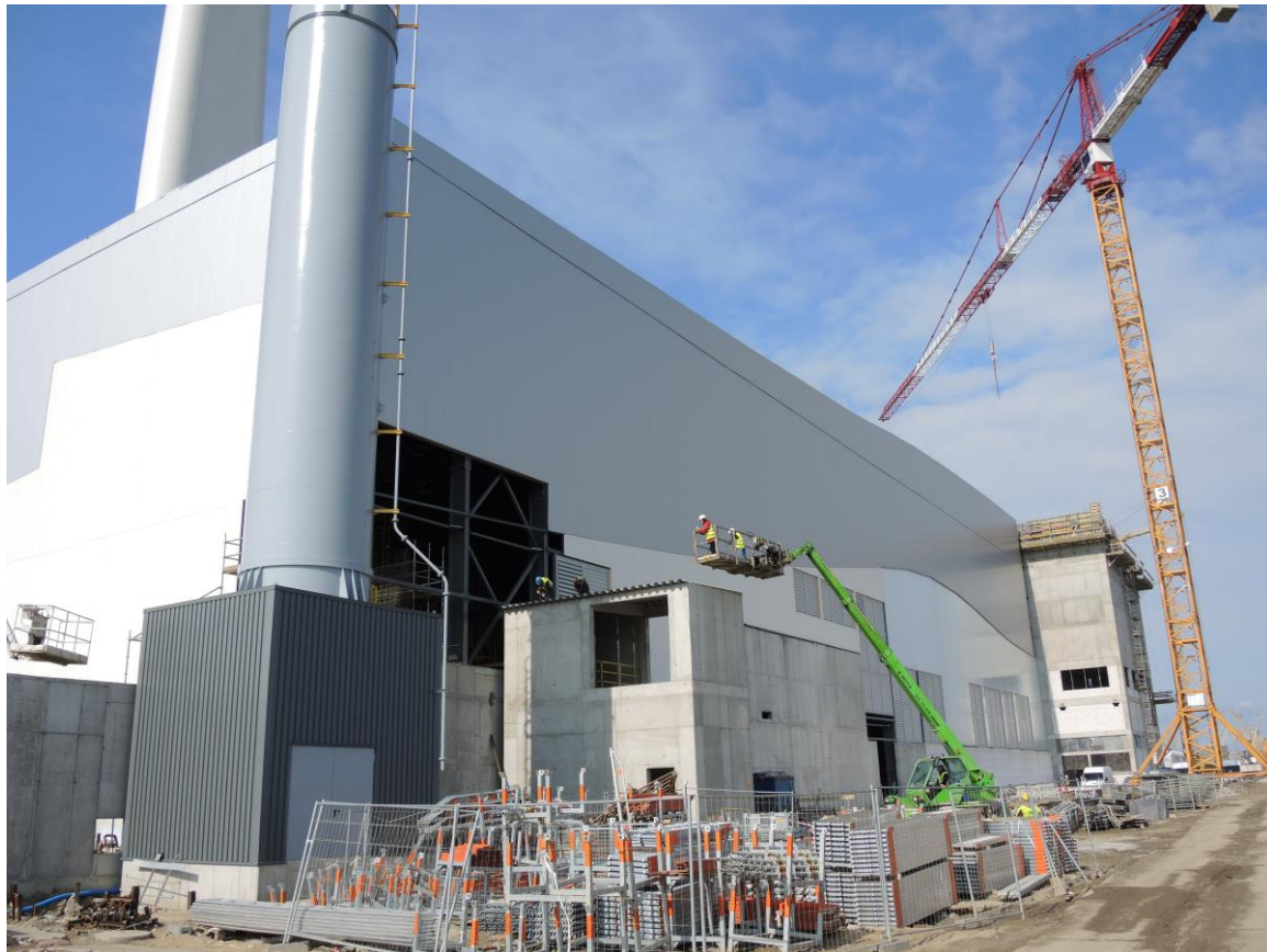
EcoGenerator w budowie
